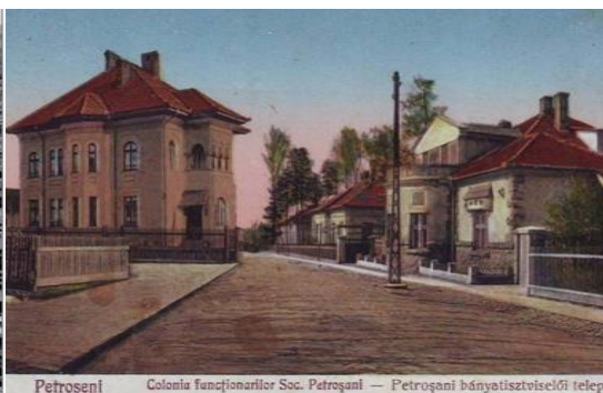
Foto. 2 Colonia funcționarilor Societății Petroșeni
